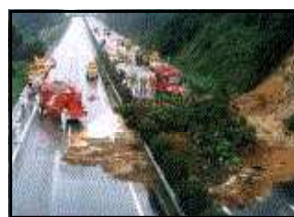
図1 土砂崩れの様子
