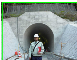
図13 トンネル入口
