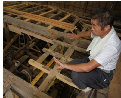
高橋 国良さん 舞台の修復工事 担当
